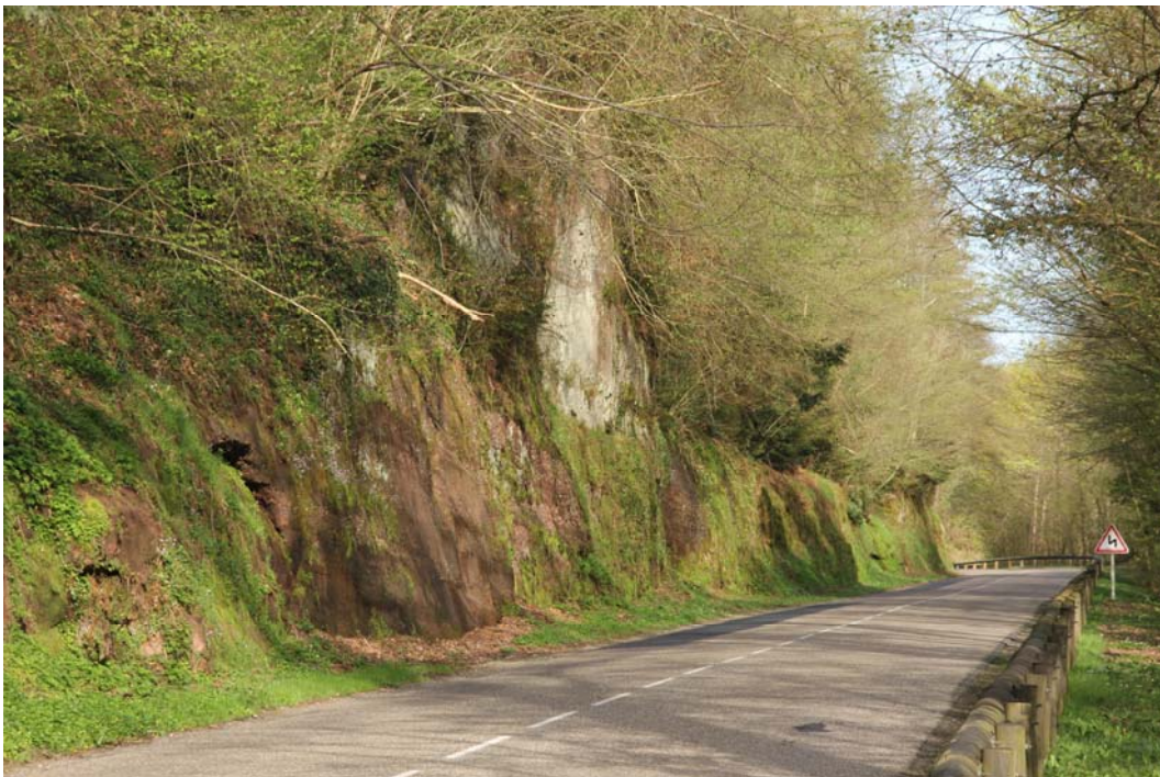
Abb. 2: Felswand am Straßenrand im Rehtal im April 2011.
